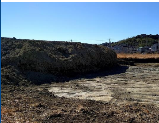
市有地の土を運んで、新スマートインターに使います。
